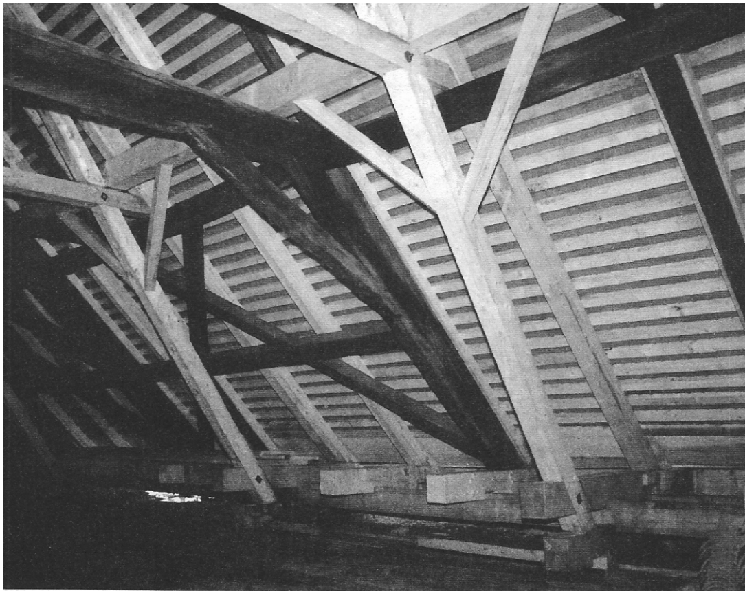
Ukázka kvalifikovaně opraveného a sanovaného barokního krovu.
